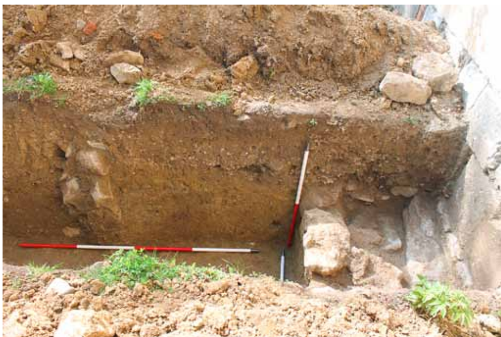
8. kép. A templom barokk lábazata és a visszabontott középkori falak Fig. 8. The Baroque plinth and the dismantled medieval walls
