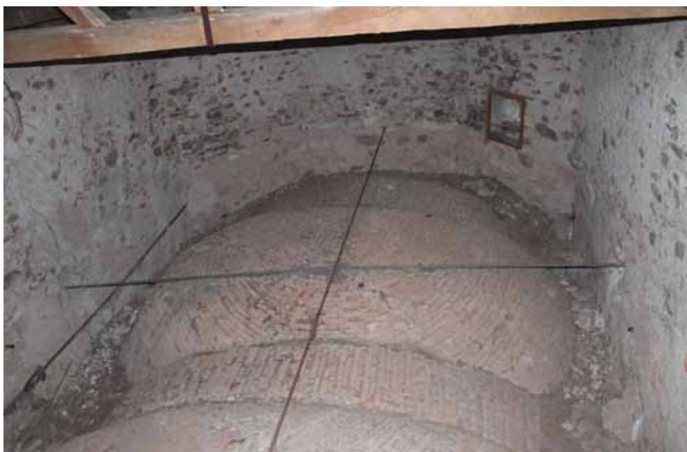
5. kép. A barokk boltozat és a gótikus falak viszonya
